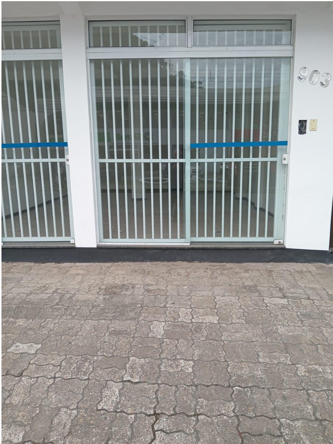
Foto 5 – Calçamento tipo paver
